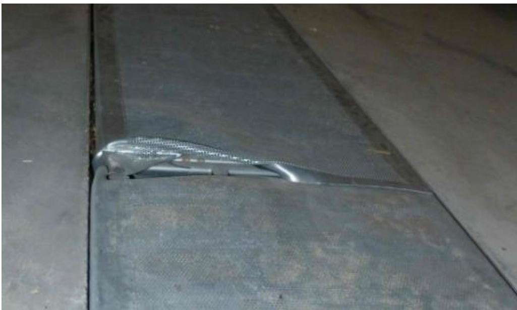
Abbildung 6: Beschädigtes Element durch falsches Auslegen der Abdeckungen
